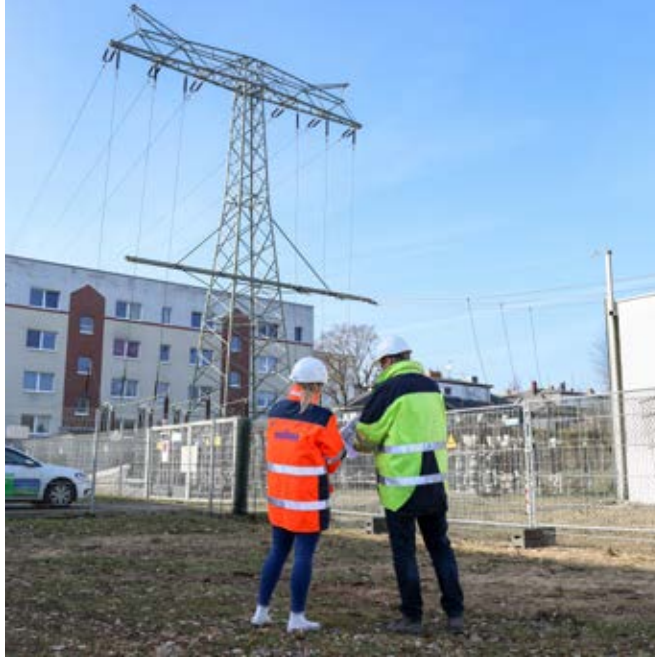
Mitarbeiter der Netzgesellschaft besprechen bei einem Vorort-Termin den Stand und die weiteren Planungen auf dem Gelände des neuen Umspannwerkes
